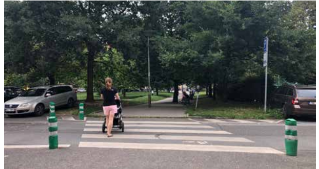
25 Přístup jižní - z Korejské ulice (a pěším průchodem z Rooseveltovy ulice), bez sníženého obrubníku, sloupky zabráňující parkování.
