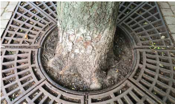
35 Poškození stromů psí močí, mříž omezující růstový potenciál stromu a stlačující kořenové náběhy
