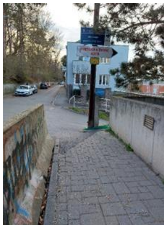
Obrázek 2.12: Nedostatečná šířka chodníku.
