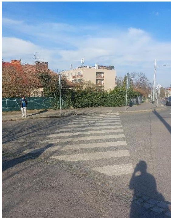
Obrázek 2.4: Nevhodně provedené VZD přechodu.
