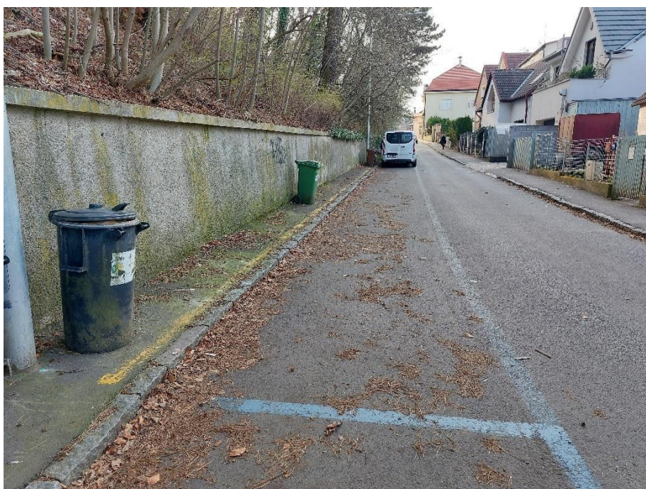
Obrázek 2.2: Nevyhovující šířkové uspořádání.
