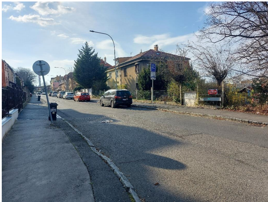
Obrázek 2.15: Nevhodně provedené povrchy v celé šířce uličního prostoru.
