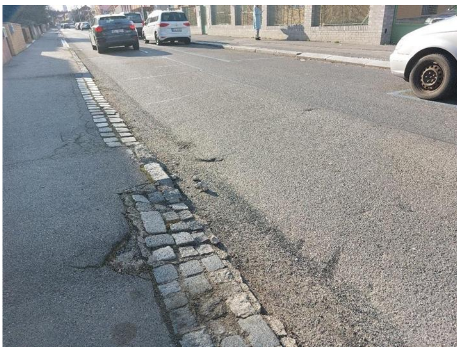
Obrázek 2.16: Sklopené obruby u vjezdů.
