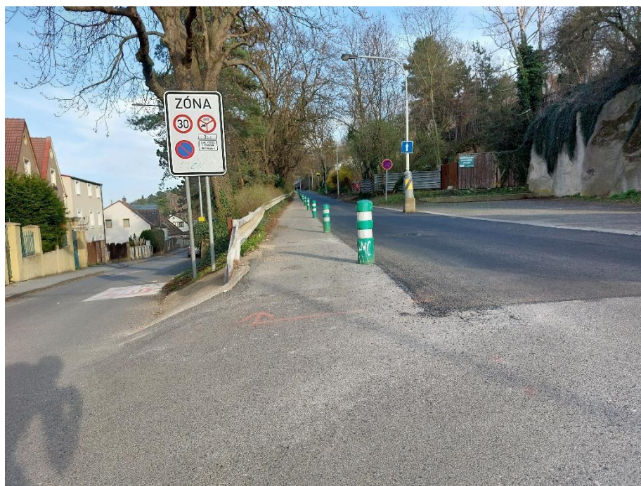
Obrázek 2.13: Rozdílná výšková úroveň ramen křižovatky.
