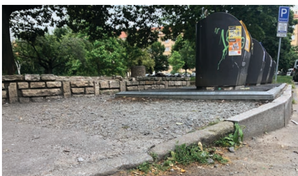
24 - nádoby na tříděný odpad zneprůchodňují chodník
