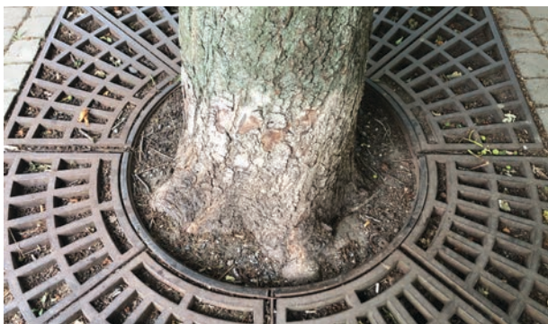
35 Poškození stromů psí močí, mříž omezující růstový potenciál stromu a stlačující kořenové náběhy
