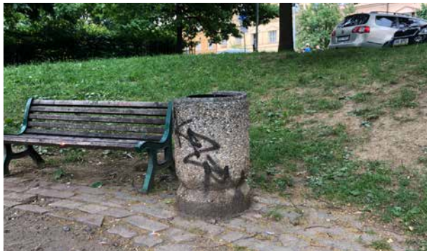
Stávající lavičky staršího typu, některé celkem obnovené, většina v opotřebeném stavu, obzvláště na dětském hřišti.
