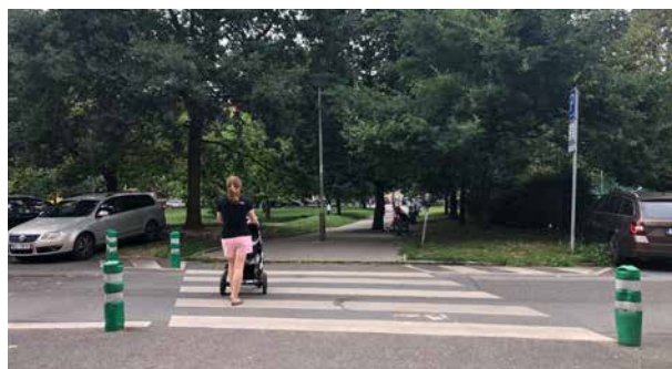
02 Přístup jižní - z Korejské ulice (a pěším průchodem z Rooseveltovy ulice), bez sníženého obrubníku, sloupky zabíhající parkování.
