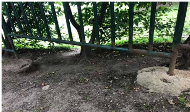
Kotvení nosných stojek
