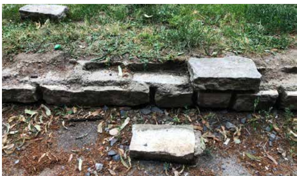
Stav terénní zídky u jižní parkové stezky
