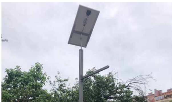
Mlžidlo na solární panel
