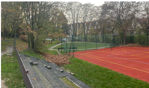
28 Část území zabírá oplocené sportoviště s koši na basketbal, které má relativně nově upravený povrch. Na sportoviště navazuje tribuna ve velmi opotřebeném stavu.
